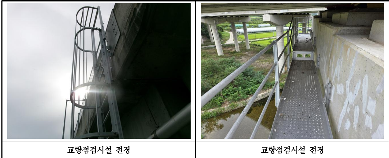
【사진 16.3.26】 교량 점검시설 전경
