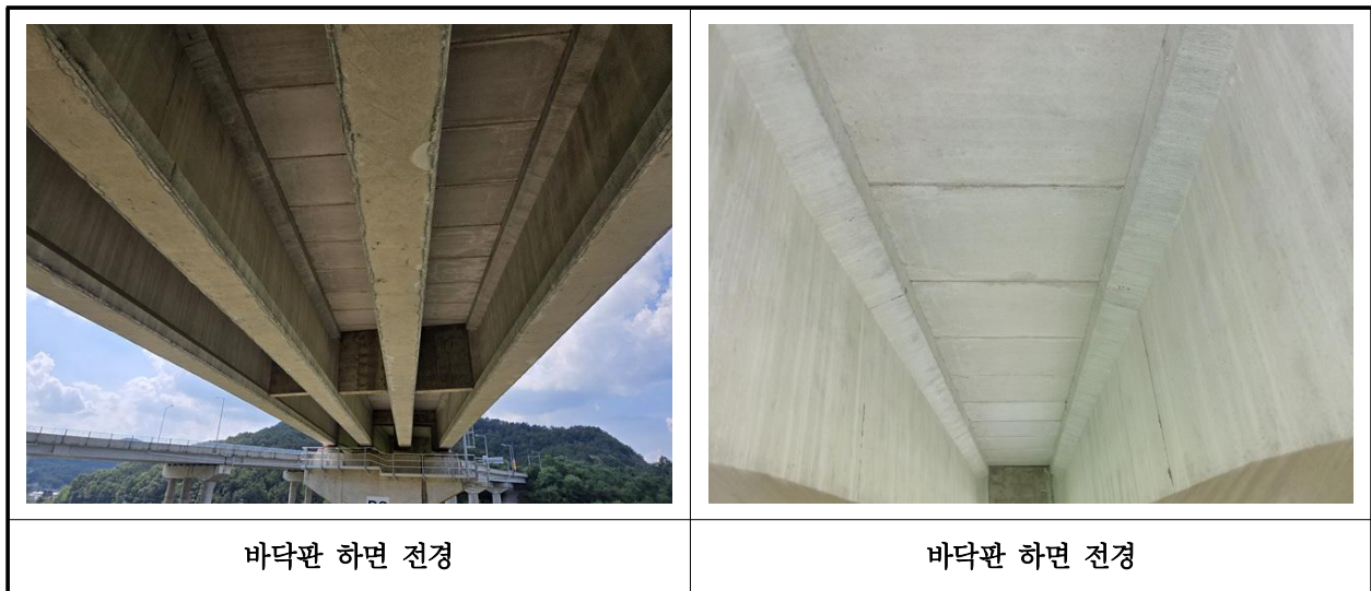
【사진 16.3.2】 바닥판하면 전경
