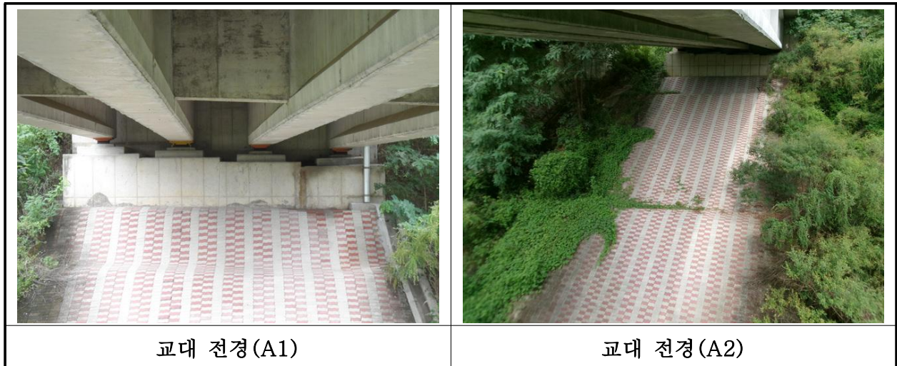
【사진 16.3.8】 교대 전경
