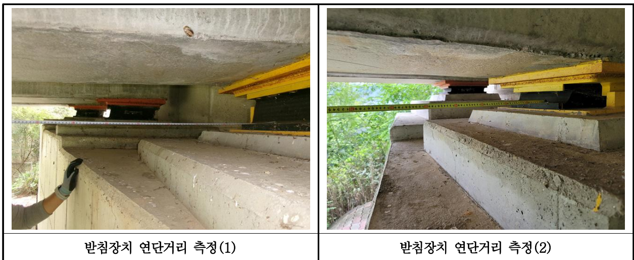
【사진 16.3.15】 교량받침장치 연단거리측정
