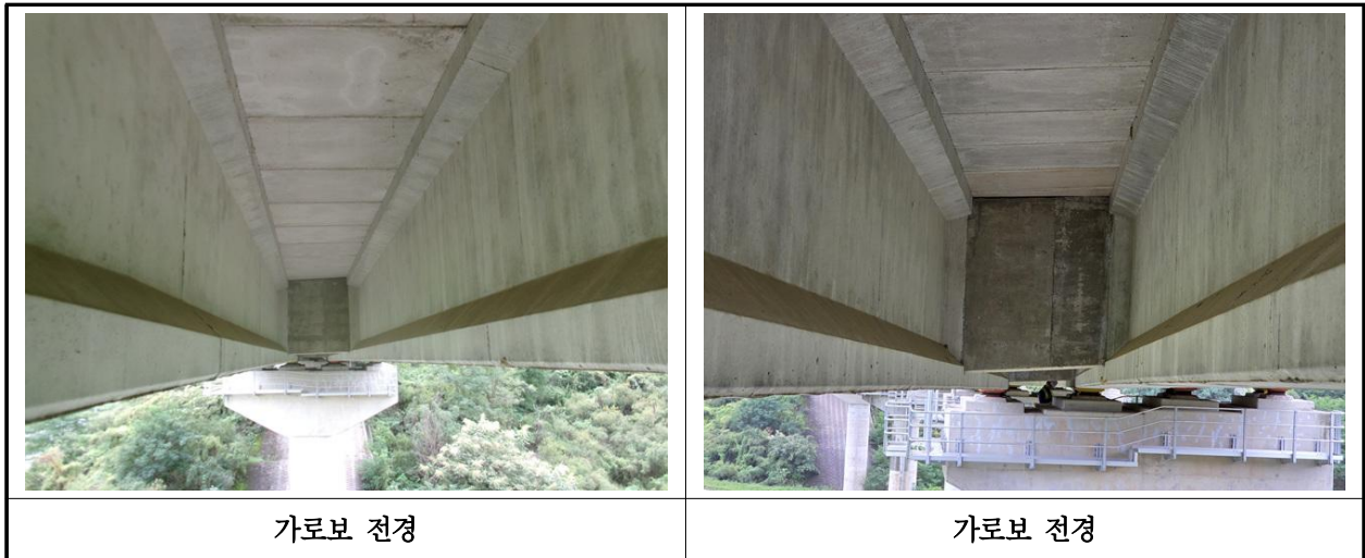
【사진 16.3.6】 가로보 전경
