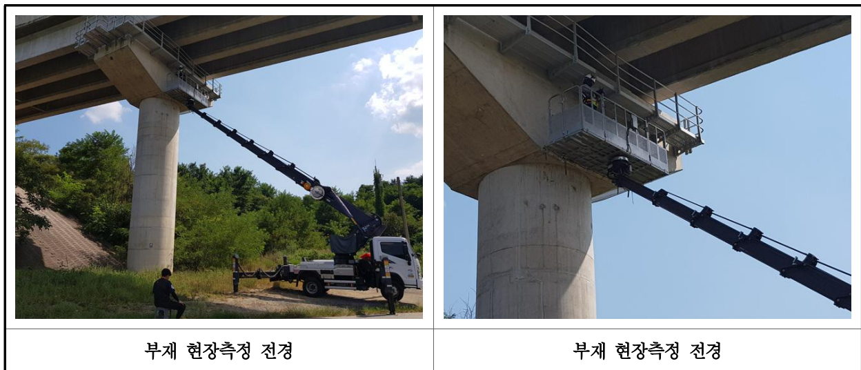
【사진 16.2.1】 부재 현장측정 전경
