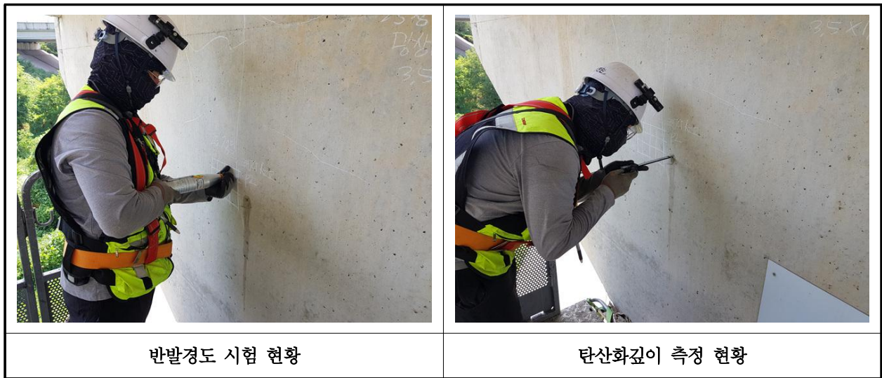
【사진 16.4.1】 콘크리트 내구성조사 현황
