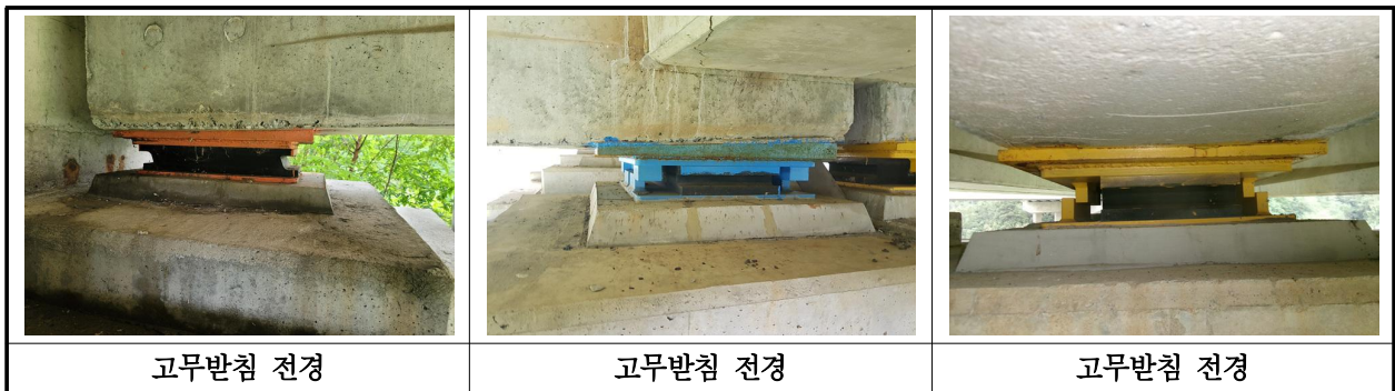
【사진 16.3.13】 교량받침 전경
